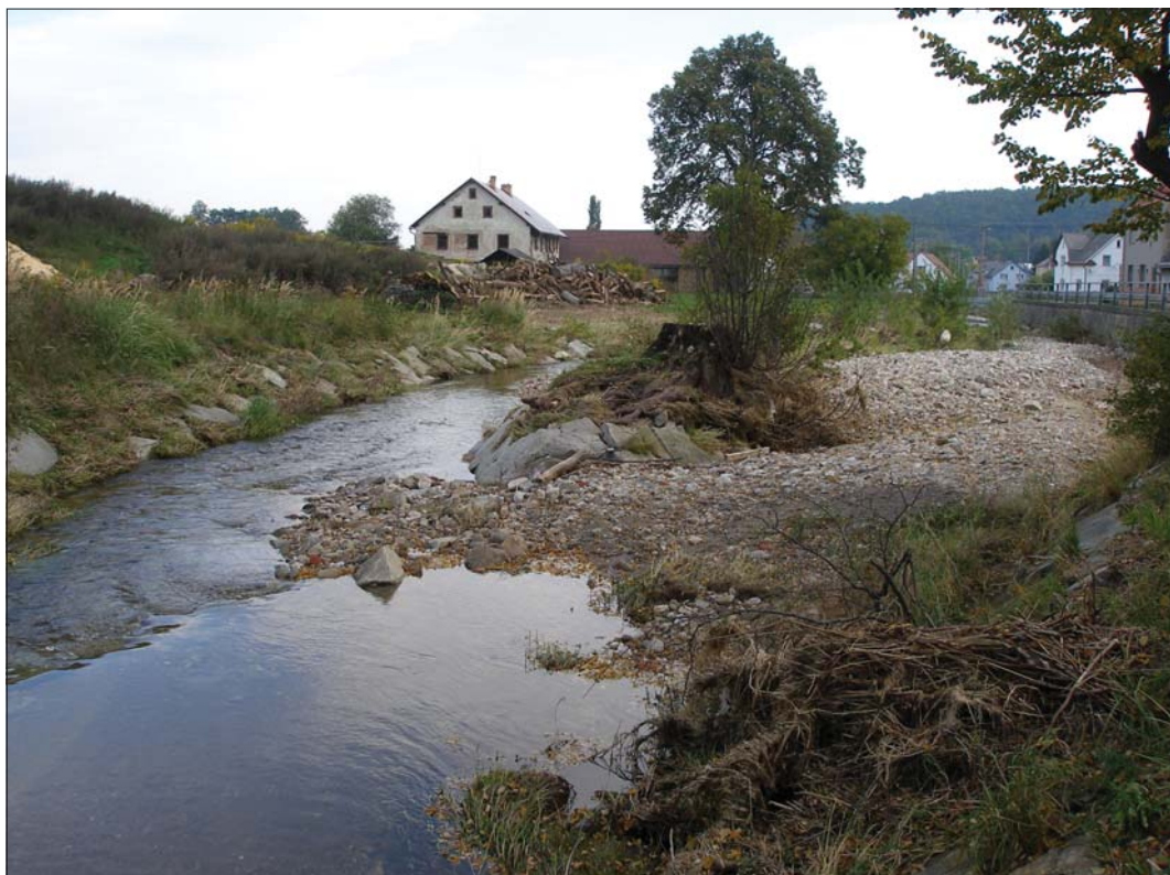
Obr. V.7 Poničené koryto Červeného potoka ve Staré Červené Vodě.
