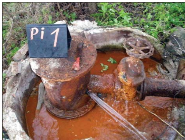
b) Písty Pi-1 (netěsné zhlaví s výtokem / untight well head with outflow ).
