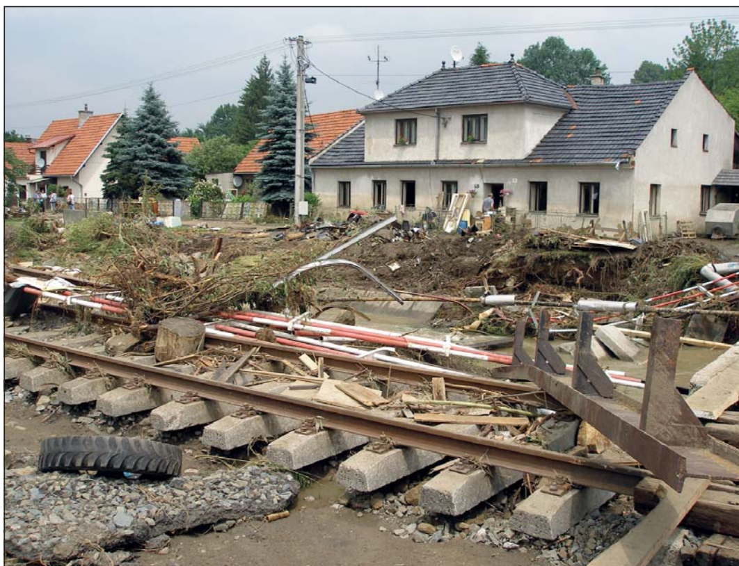
Obr. V.10 Zničené koryto toku Zrzávka v Bludovicích. Fig. V.10 River bad damage of the Zrzávka stream at Bludovice.
