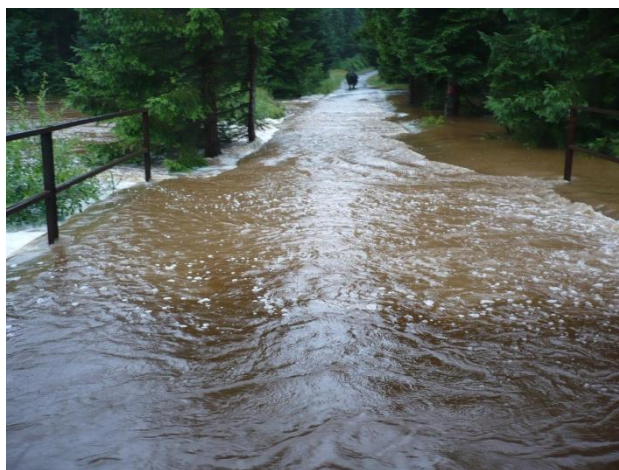
6.24 Silnice pod Novou Loukou v poledne 7.8.2010
