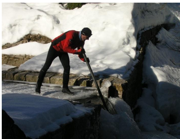
6.19 Odstraňování ledu z měrného přelivu
