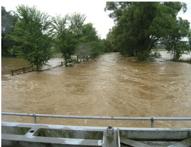
6.1 Smědá vylitá z koryta v Předáncích
