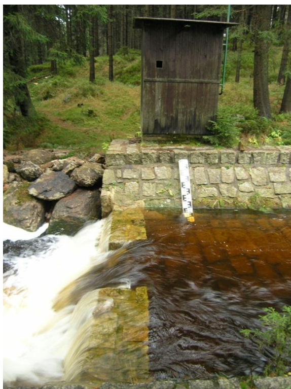
6.13 Limnigrafická stanice s kamenným vzdouvacím prahem a měrným přelivem
