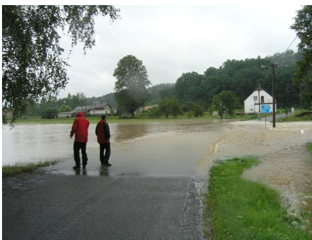
6.5 Přístup ke stanici v Předláncích je pod vodou
