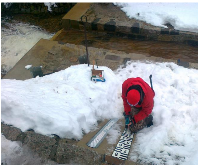
6.3 Instalace vodočetné latě na Černé Smědě 4.1.2013
