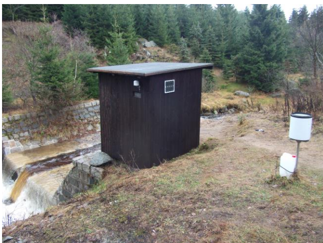
6.1 Zrekonstruovaná limnigrafická stanice na Černé Smědě 5.11.2012
