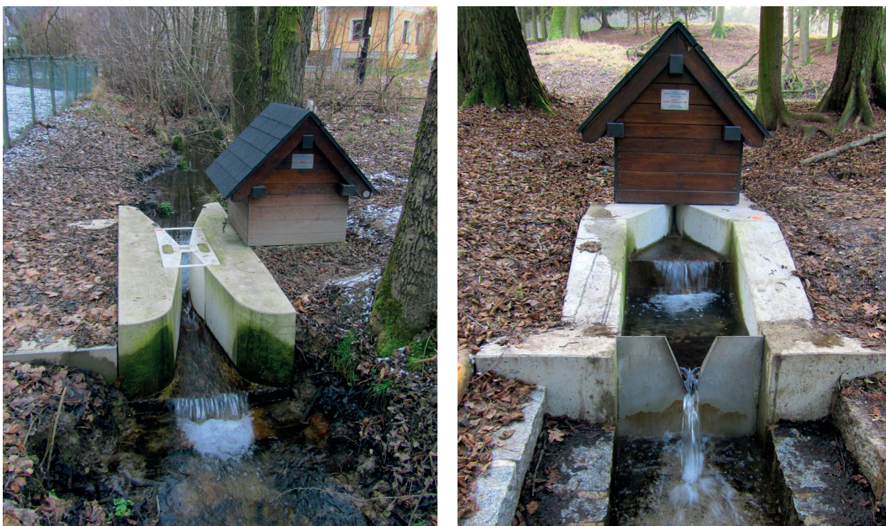
Obr. V.7 Pramen PP0197 Dolánky s Parshallovým žlabem typ P3 (vlevo), pramen PP0174 Mcely s Parshallovým žlabem typ P1 v kombinaci s trojúhelníkovým přelivem (vpravo).
